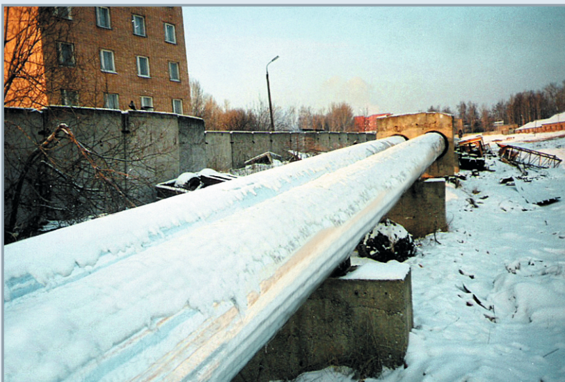
Теплотрасса, диаметр 720 мм, рабочая t +130^{\circ}\text{C} Смоленские тепловые сети.
