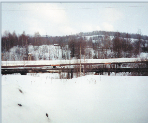
Кизеловская ГРЭС. Паропровод, диаметр 630 мм. t_{\text{раб}} = +380^{\circ}\text{C} .
