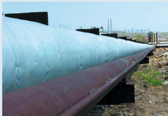
Внешний вид тепловой изоляции паропровода после монтажа СТУ.
