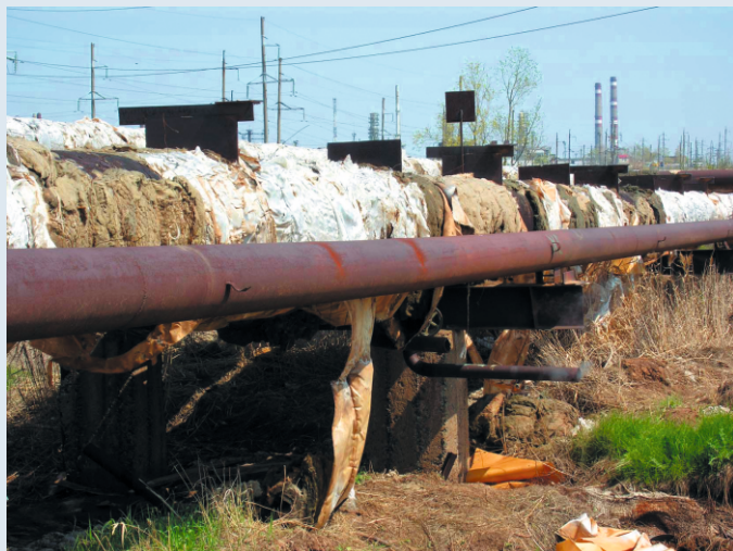
Внешний вид тепловой изоляции паропровода до монтажа СТУ.
